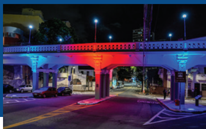
Prefeitura Municipal de Vitória - Viaduto Caramuru
